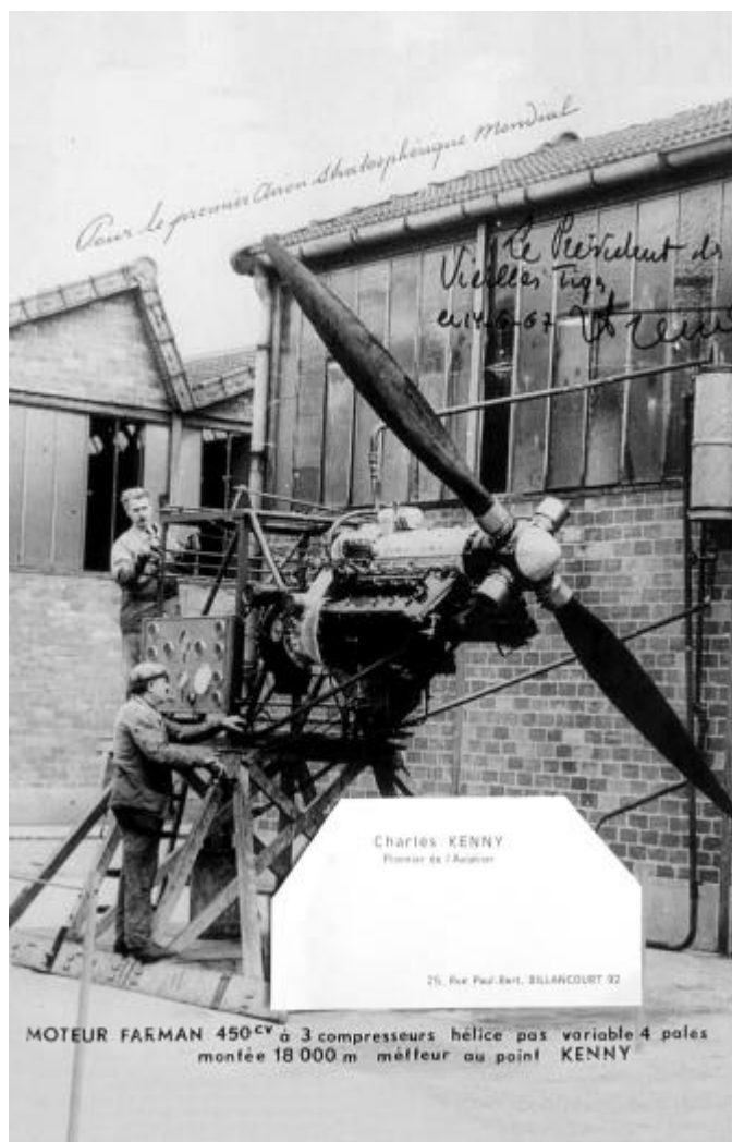
Moteur Farman destiné aux vols en haute altitude (20.000 m).
