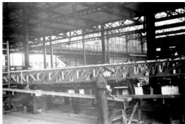
Construction à Billancourt du caisson central de voilure du Farman 221 en 1935. (Archives municipales de Boulogne-Billancourt).
