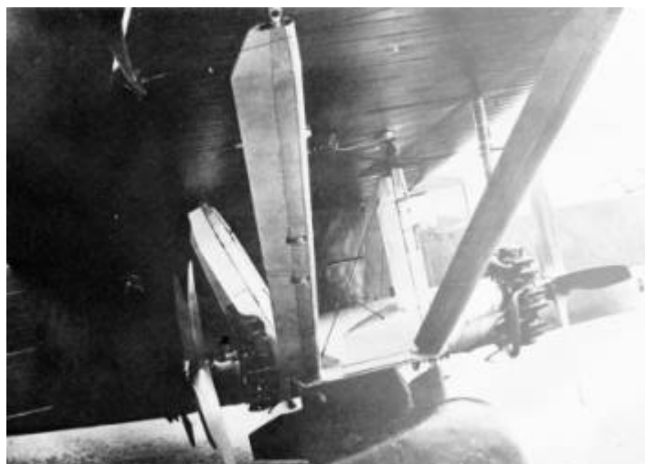
Le Farman 211, premier quadrimoteur de bombardement (1931). Cette photographie montre la disposition des moteurs sous l'aile.
