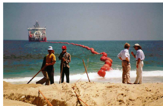
Atterrissement d'un câble sous-marin. © Tous droits réservés.
